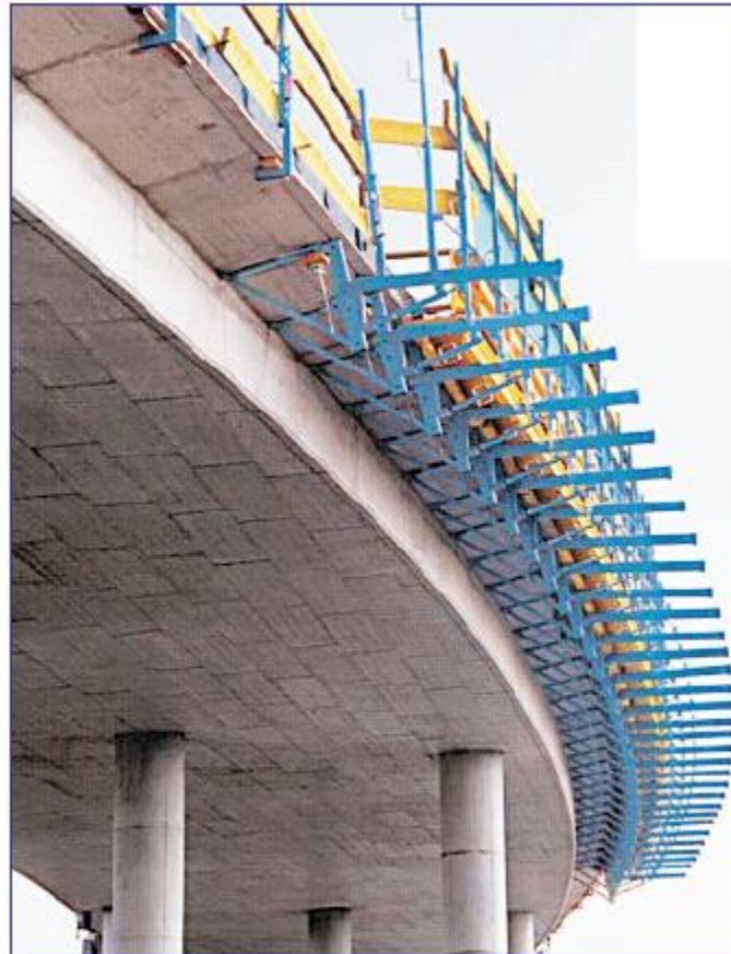
Fig. 5.7 Edge beam formwork
